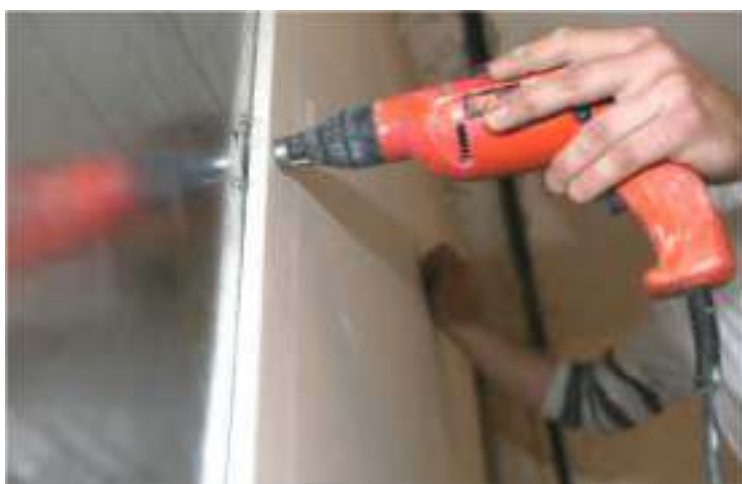
5.- APLACADO SOBRE LA ESTRUCTURA
