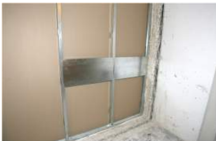
4.- SOPORTES DE CARGA INSTALADOS
