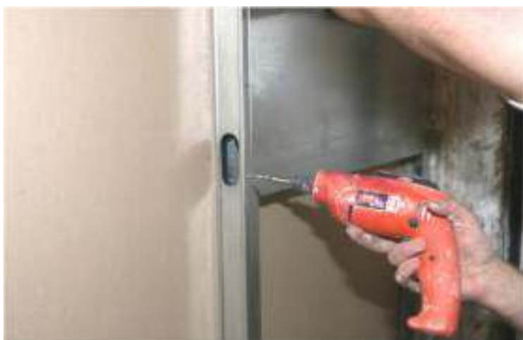
3.- FIJACIÓN A LOS MONTANTES VERTICALES
