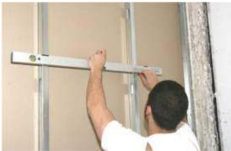
1.- REPLANTEO DE LA POSICIÓN DEL SOPORTE
